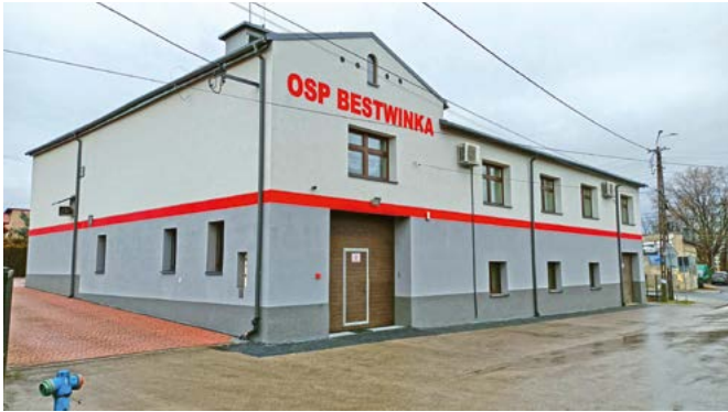
Budynek OSP Bestwinka po termomodernizacji
